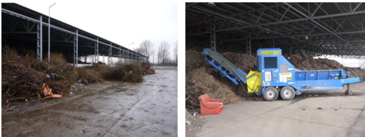
Figura 4-8: Stația de compostare Galați
