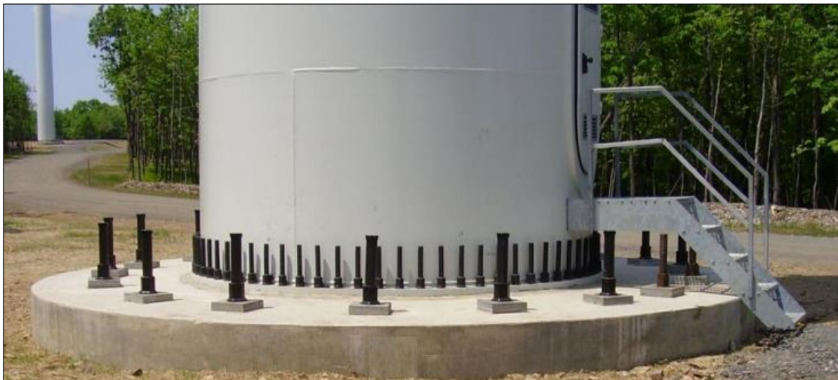
Figura 2-5: Ancorare turbina pe fundație
