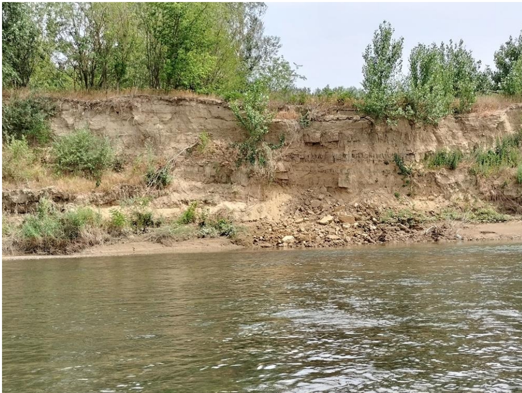
Figura 8 Detaliu eroziune mal drept
