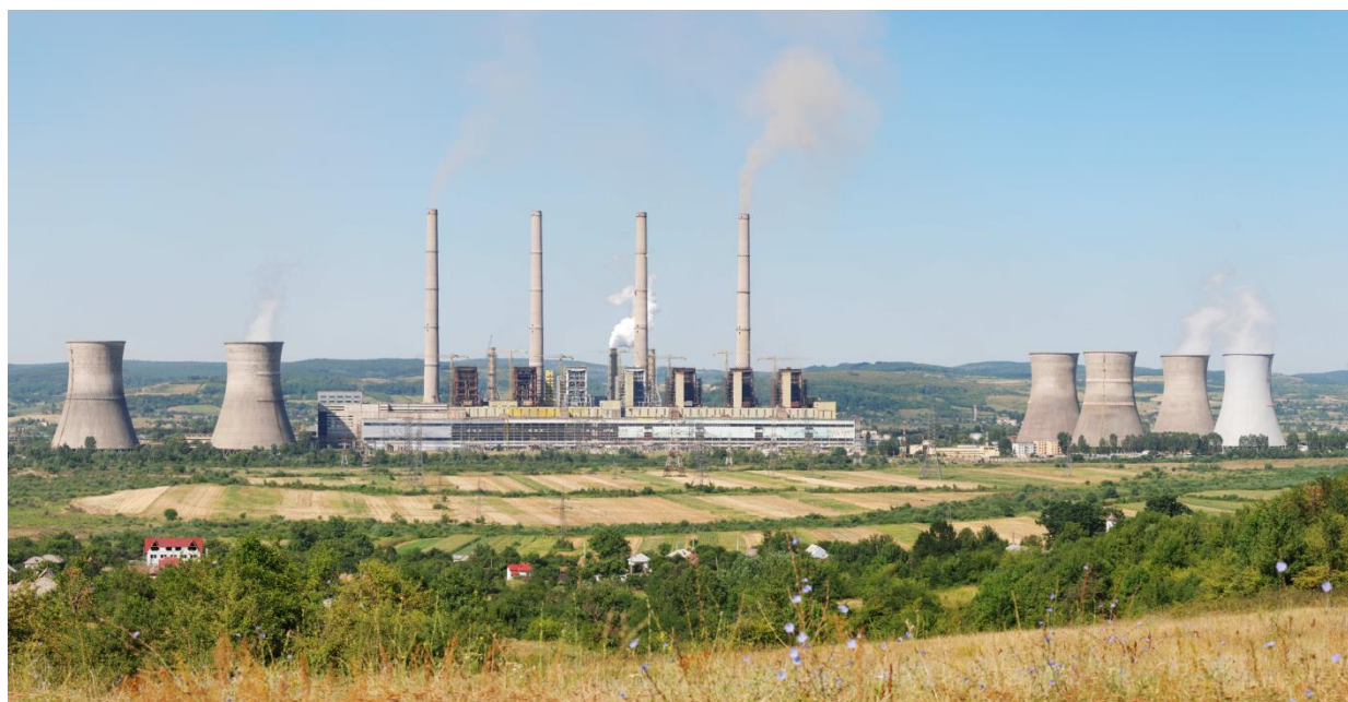
Figura nr. 1. 1 Centrala termoelectrică Turceni
