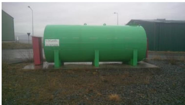
Platforma betonată sub rezervor de motorină
