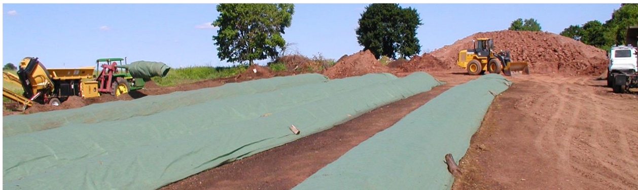
Figura 2.16. Membrana semipermeabilă Tencate Top – Tex Coverfabric
