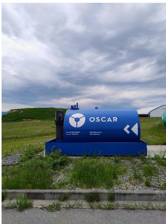
Figura 2.3. Stație de carburanți
