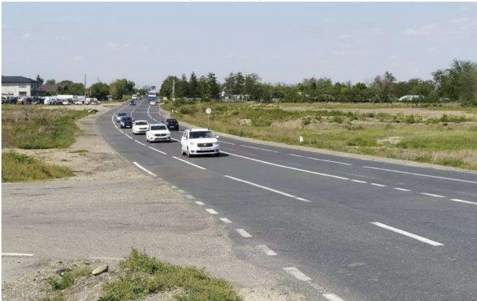
Figura 1. Vedere din intersecția Drum comunal – DN2/E85 spre Nord (terenul aferent Parcului Industrial este în partea sângă a pozei)
