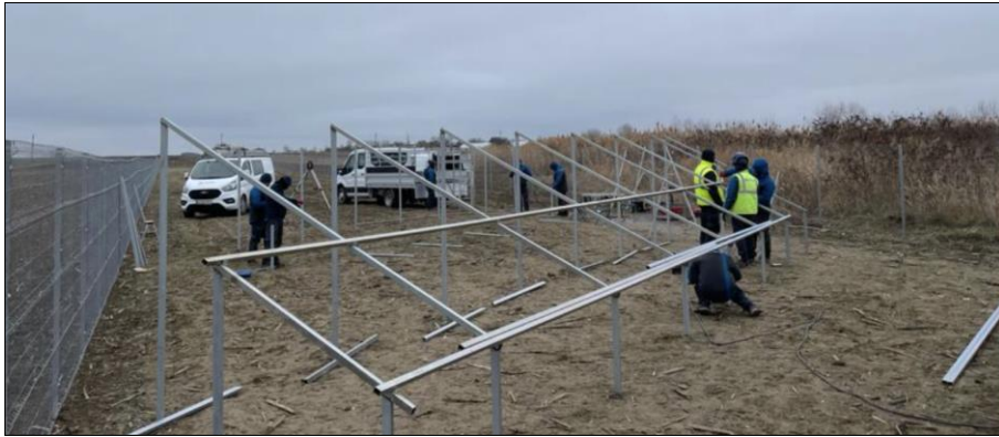
Figura 5. Realizare structură metalică de susținere panouri fotovoltaice (exemplificare dintr-un proiect similar).
