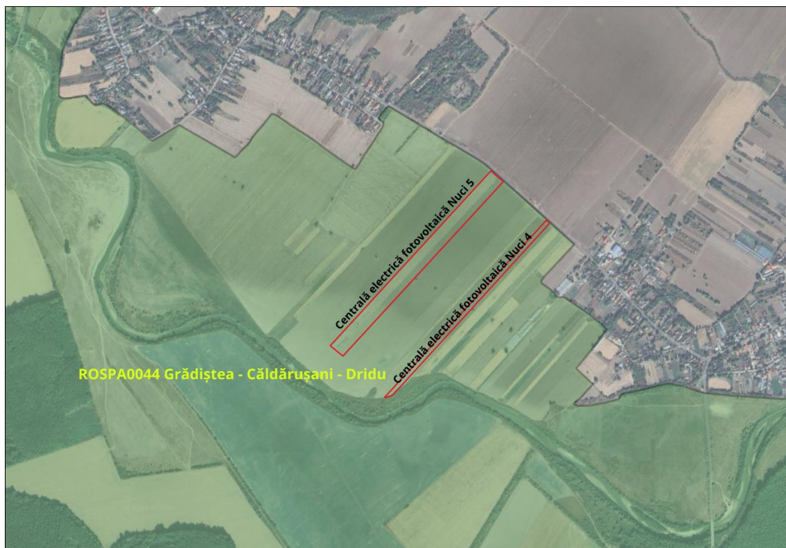
Figura 15. Amplasamentul centralei electrice fotovoltaice Nuci 4 în raport cu centrala electrică fotovoltaică Nuci 5.
