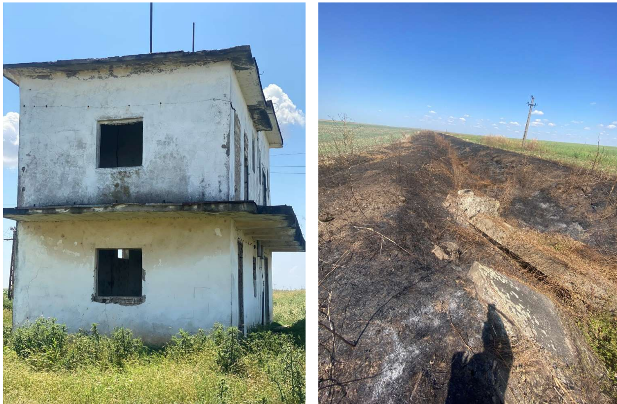
Figura nr. 3: Stația de repompare SRPA 4
