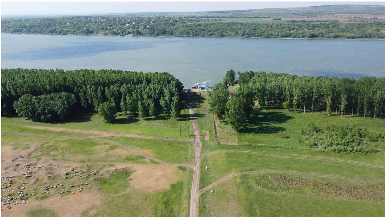
Figura nr. 16 - Amplasament conducte refulare subterane de la SPA Salcia la bazin refulare CA2 – vedere aeriana
