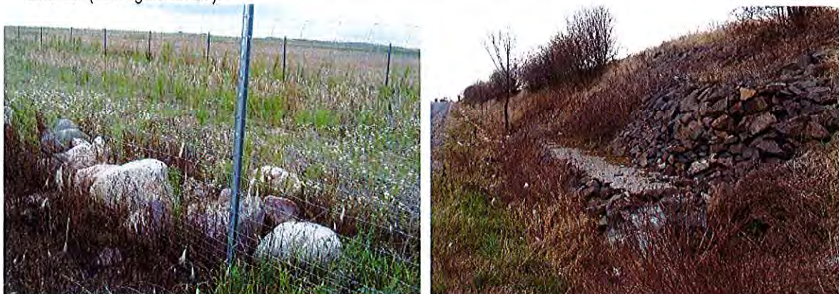
Figura 57. Utilizarea de bolovănișuri ca microhabitate este în măsură a oferi nișe suplimentare ecologice (stânga) și funcționând ca zone de drenaj a apelor de spălare ce contribuie substanțial la stabilizarea pantelor (dreapta)
