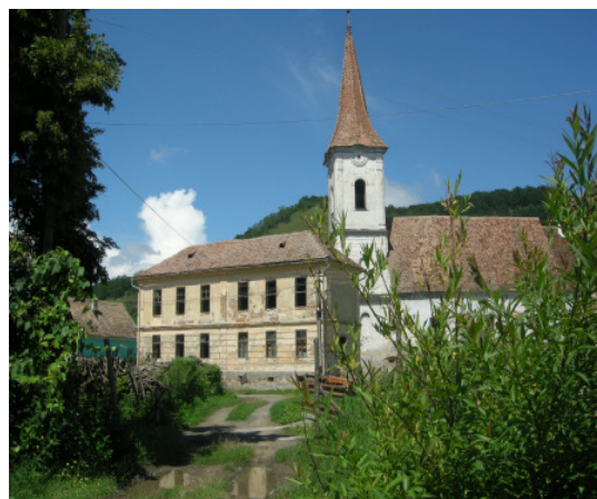
Vedere cu drumul de acces dinspre DJ 151B
