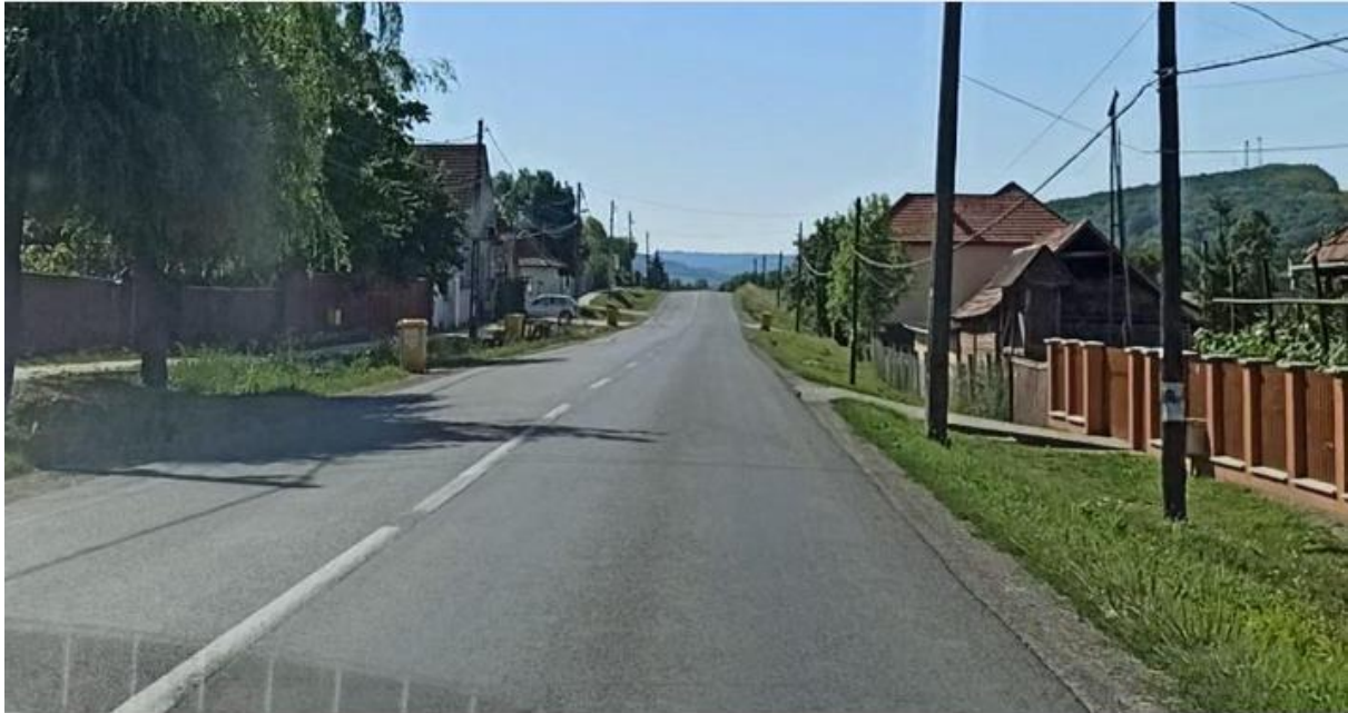
Figura 2 Zona de amplasament km 15+880
