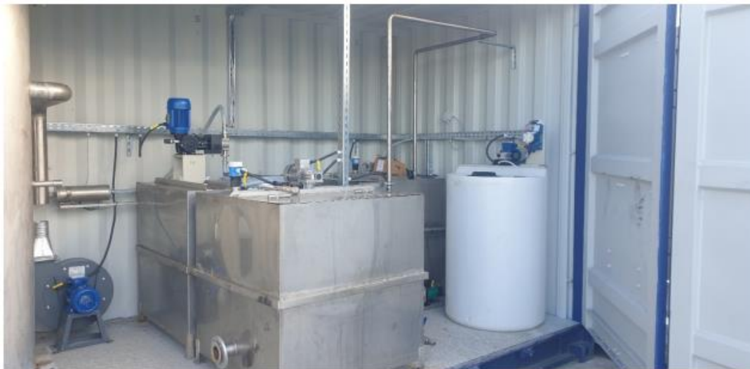
Figura 11 Detaliu de colectare, tratare ape impurificate, cu preparare și dozare automată
