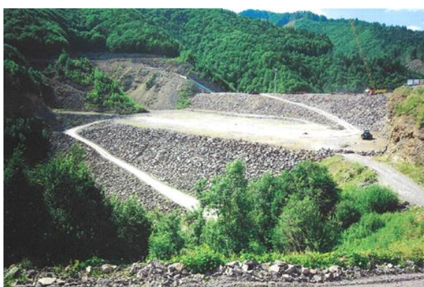
Figura 6 - Baraj Răstolița. Vedere dinspre aval în etapa provizorie
