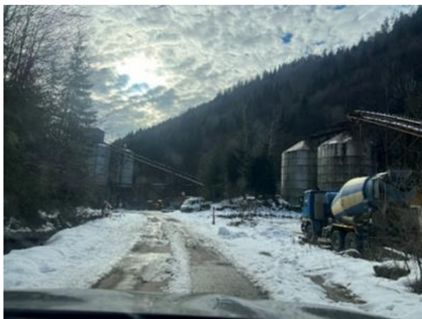
Figura 16 - Stația de beton
