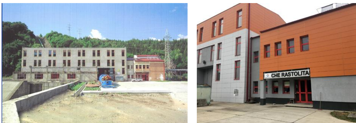
Figura 9 - CHE Răstolița - Clădirea centralei în etapa provizorie și etapa finală
