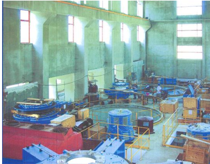
Figura 10 - CHE Răstolița - Sala mașinilor în faza de montaj hidroagregate
