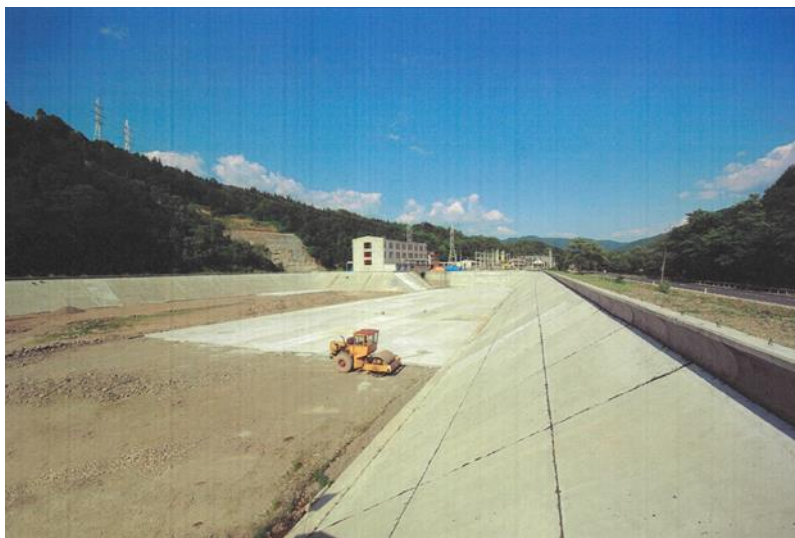
Figura 11 - CHE Răstolița. Betonarea radierului bazinului de compensare din aval de centrală
