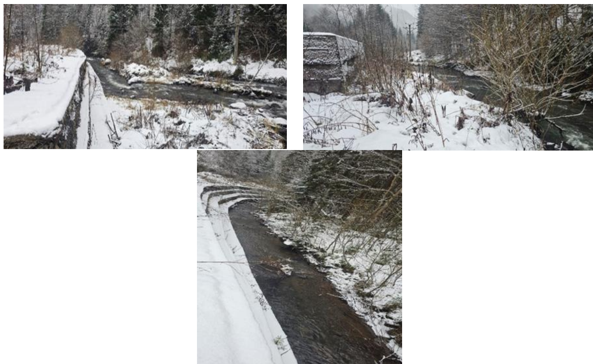
Figura 15 - Corpul de apă Răstolița, ac. Răstolița – conf. Mureș în zona de intersecție cu proiectul (regularizare aval baraj)
