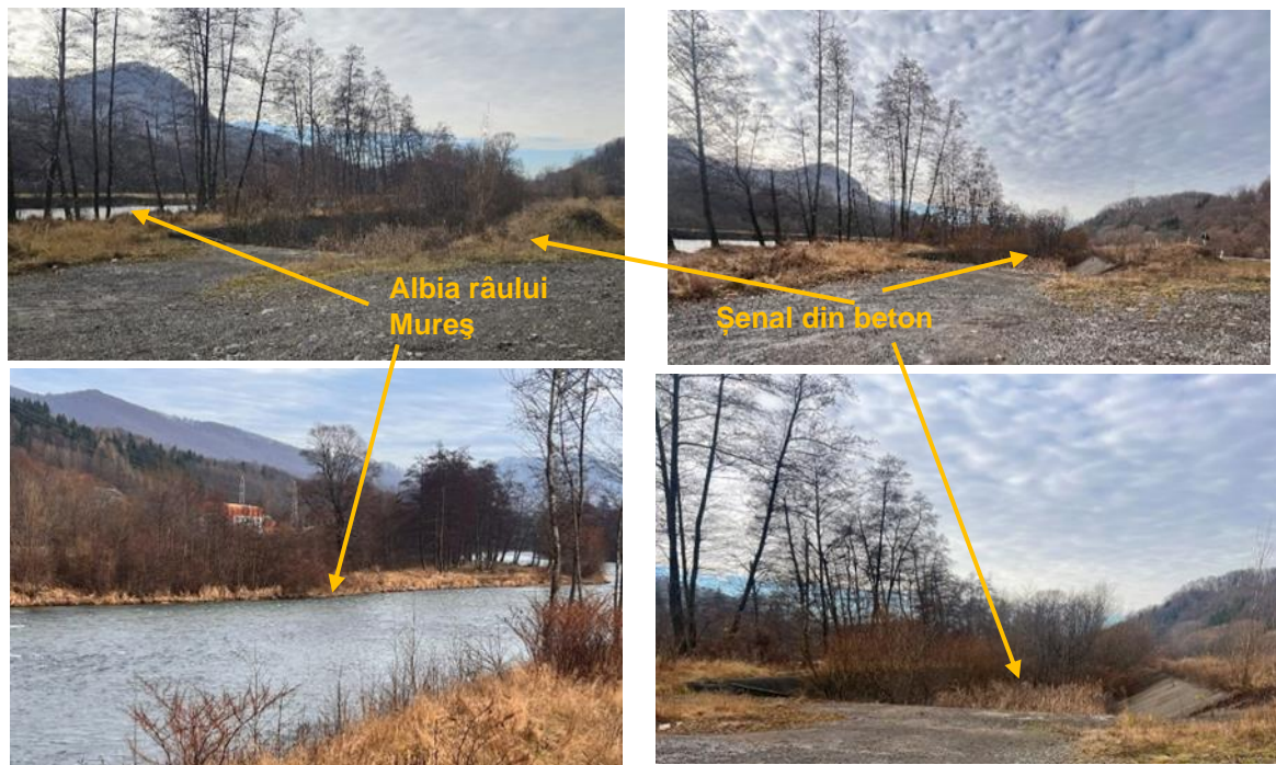
Figura 13 - Corpul de apă Mureș, conf. Toplița – Conf. Pietriș în zona de intersecție cu proiectul (debușare CHE Răstolița)
