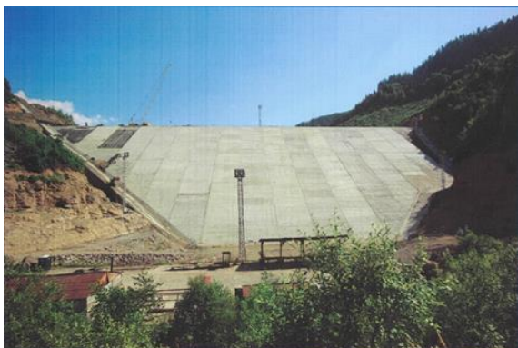
Figura 4 - Baraj Rastolița. Betonarea măștii de etanșare de la paramentul amonte
