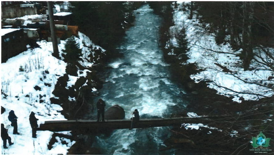
Fig. 119 Perspectivă din secțiunea măsurată în aval de baraj, cu vedere spre direcția de curgere
