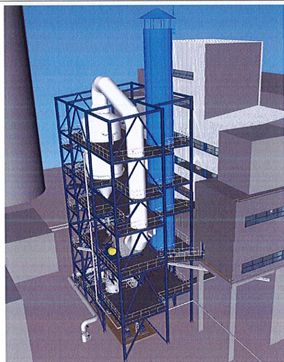
Fig. 5 – Coș evacuare scruber S 3201 (indicat în foto cu săgeată)
