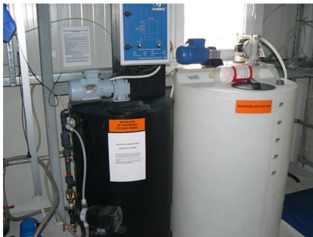
Fig. 6 Detaliu sistem de preparare și dozare chimicale
