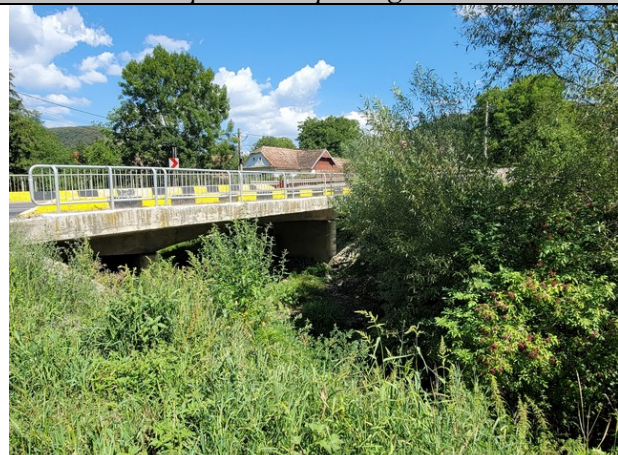
Foto. 4 – Vedere dinspre aval
