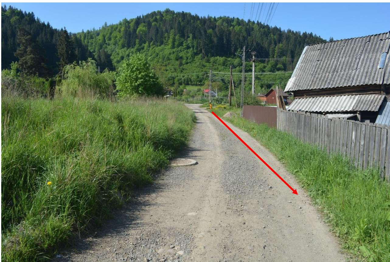
Pozare conducta de aductiune pe marginea drumului public
