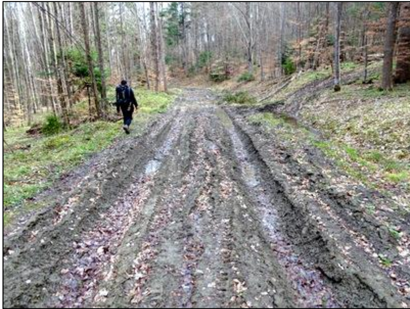
Figura nr. 10 – Aspect privind zona de suprapunere a amplasamentului drumului forestier Versant Izvorul Alb cu un drum de pământ pentru colectarea lemnului (drum de tractor) în perimetrul u.a. 56
