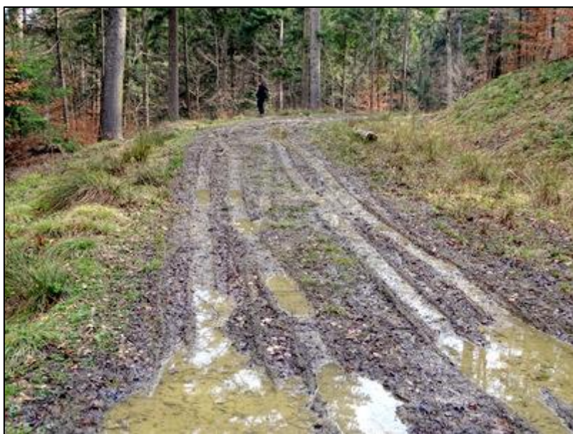
Figura nr. 11 – Aspect privind zona de suprapunere a amplasamentului drumului forestier Versant Izvorul Alb cu un drum de pământ pentru colectarea lemnului (drum de tractor) în perimetrul u.a. 57
