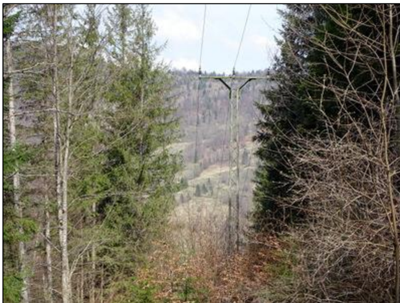
Figura nr. 19 – Aspect privind zona de intersecție a amplasamentului drumului forestier Versant Izvorul Alb cu o linie electrică aeriană de medie tensiune ce străbate unitatea amenajistică 53R
