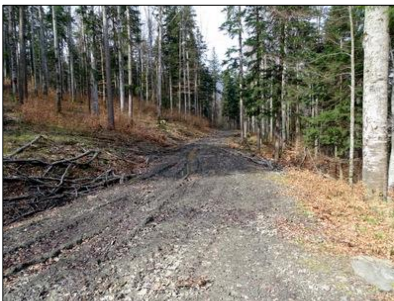
Figura nr. 20 – Aspect privind zona de suprapunere a amplasamentului drumului forestier Versant Izvorul Alb cu un drum de pământ pentru colectarea lemnului (drum de tractor) în perimetrul u.a. 55
