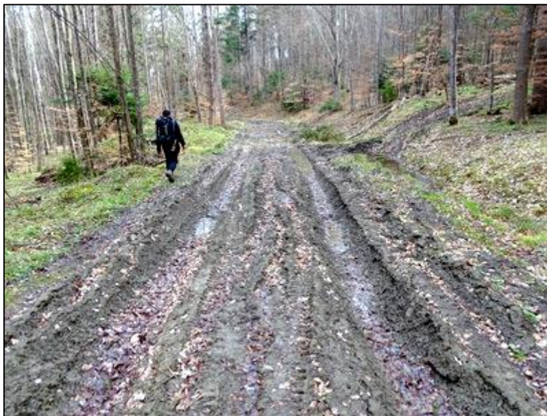
Figura nr. 21 – Aspect privind zona de suprapunere a amplasamentului drumului forestier Versant Izvorul Alb cu un drum de pământ pentru colectarea lemnului (drum de tractor) în perimetrul u.a. 56
