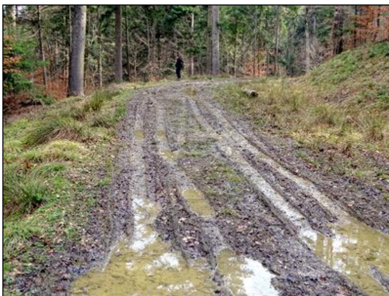
Figura nr. 22 – Aspect privind zona de suprapunere a amplasamentului drumului forestier Versant Izvorul Alb cu un drum de pământ pentru colectarea lemnului (drum de tractor) în perimetrul u.a. 57
