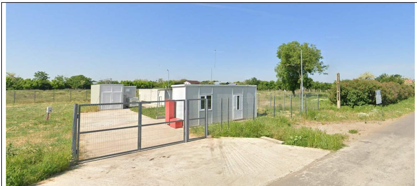
Foto 3: Teren stație de epurare existentă
