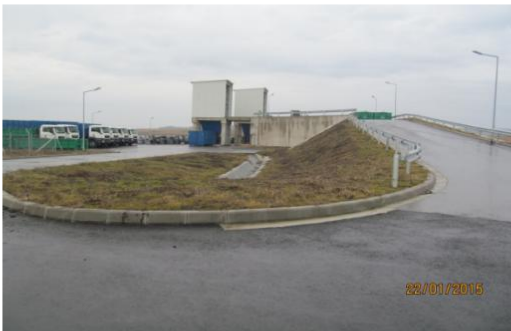
Fig. VII.1.7. Stația de transfer deșeuri din Crasna
