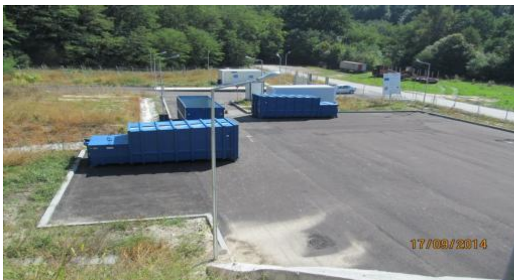
Fig. VII.1.5. Stația de transfer deșeuri din Surduc
