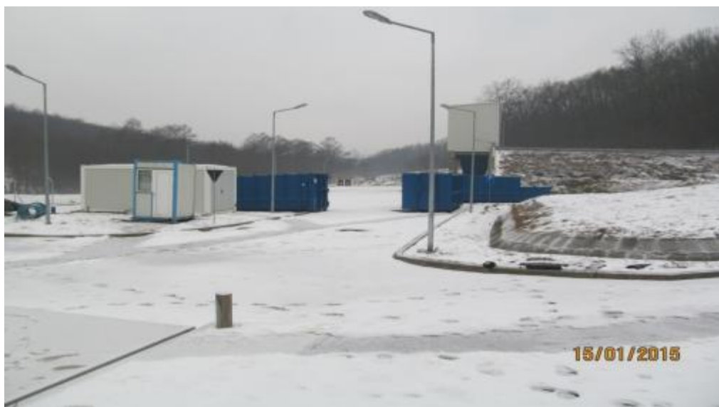
Fig. VII.1.4. Stația de transfer deșeuri din Surduc
