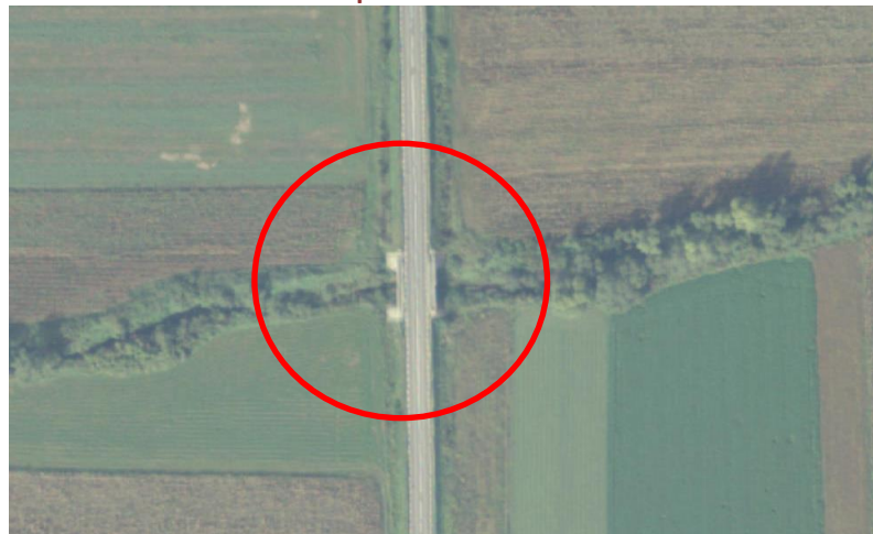
Subtraversare râu Șoimuș
