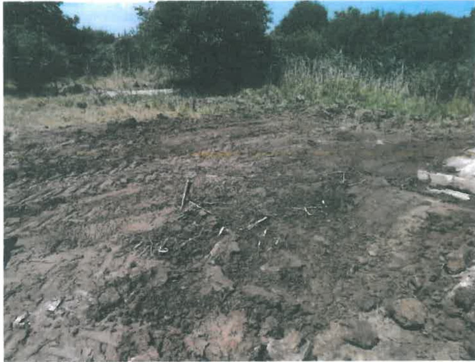
Imagine de ansamblu cu locatia sondei dupa finalizarea lucrarilor de abandonare
