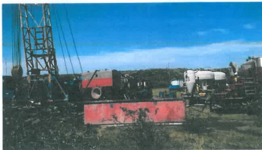
Operatia de cimentare
