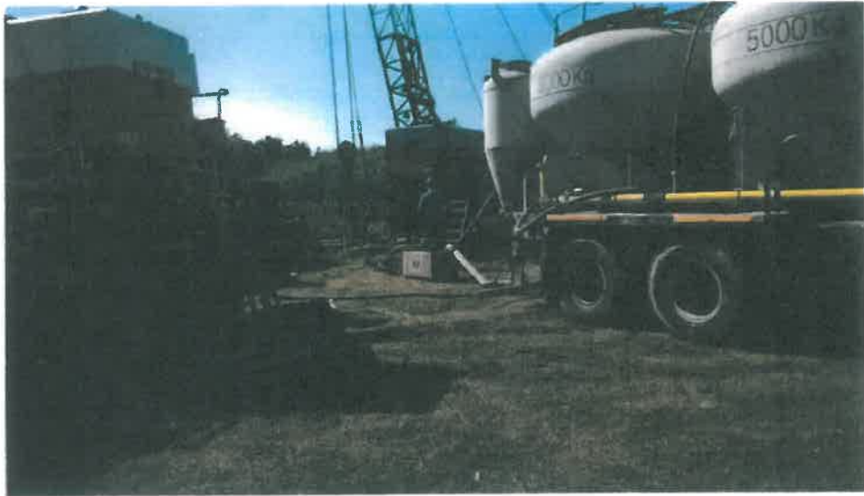
Operatia de cimentare
