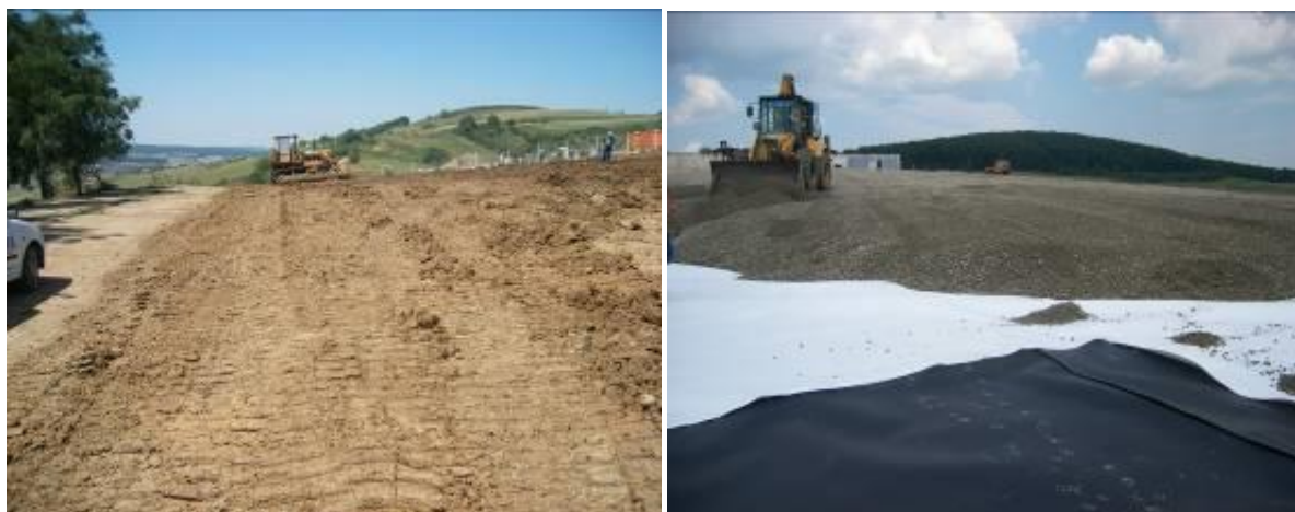
Fig.VII.1.4. Depozit în faza de închidere
