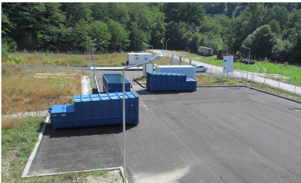
Fig.VII.1.7. Stația de transfer deșeuri din Sânmihaiu Almașului
