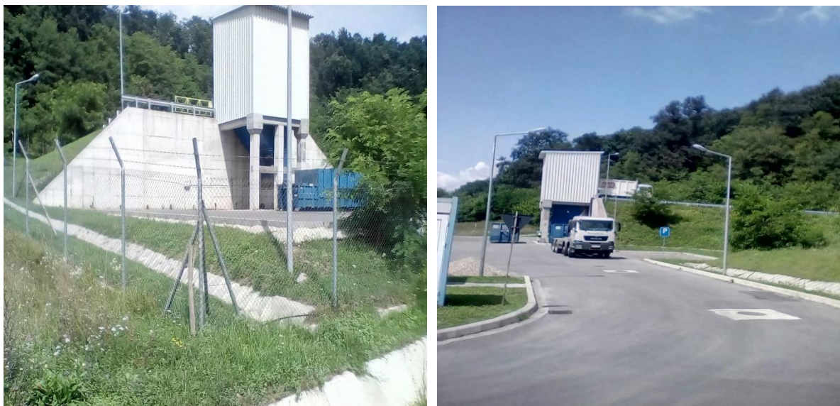
Fig.VII.1.6. Stația de transfer deșeuri din Surduc
