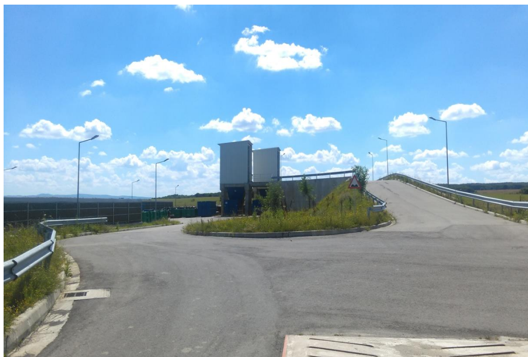
Fig.VII.1.8. Stația de transfer deșeuri din Crasna
