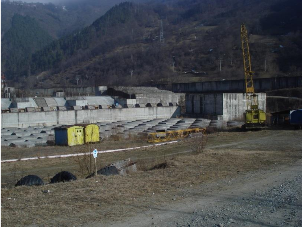
Disipatorul de energie al barajului deversor
