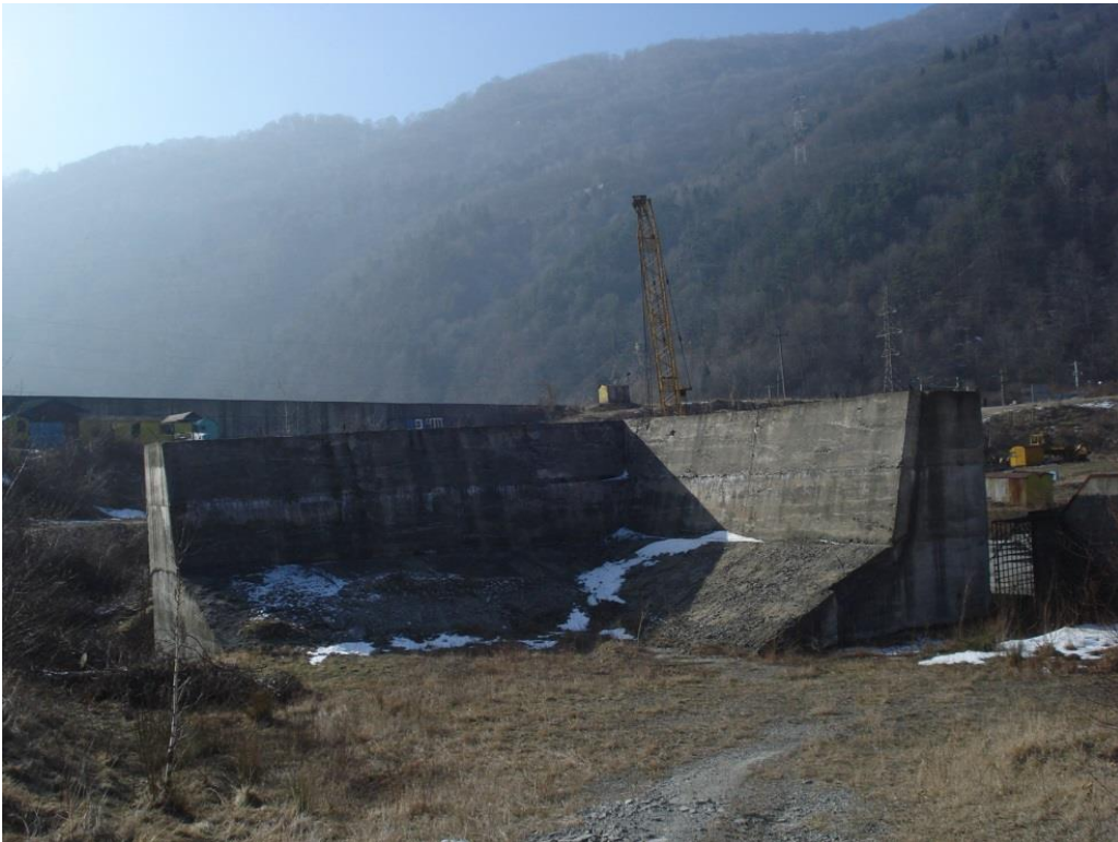
Ultimul tronson de zid aval mal stâng baraj deversor
