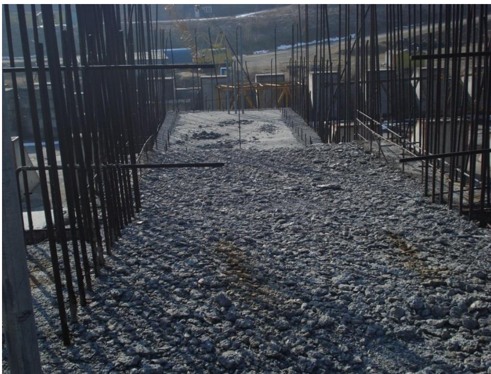
Sadiu execuție pile baraj deversor - vedere amonte aval
