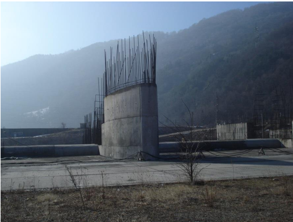
Stadiu execuție pile baraj deversor - vedere din amonte
