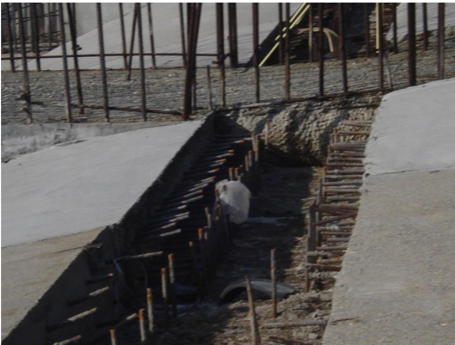
Stadiu execuție prag deversor
