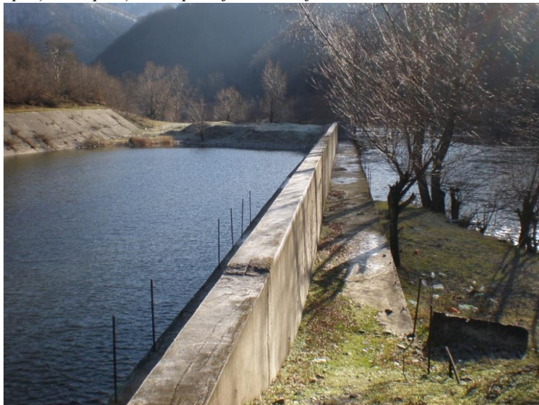
Pila despărțitoare poziționată pe mijlocul barajului deversor
