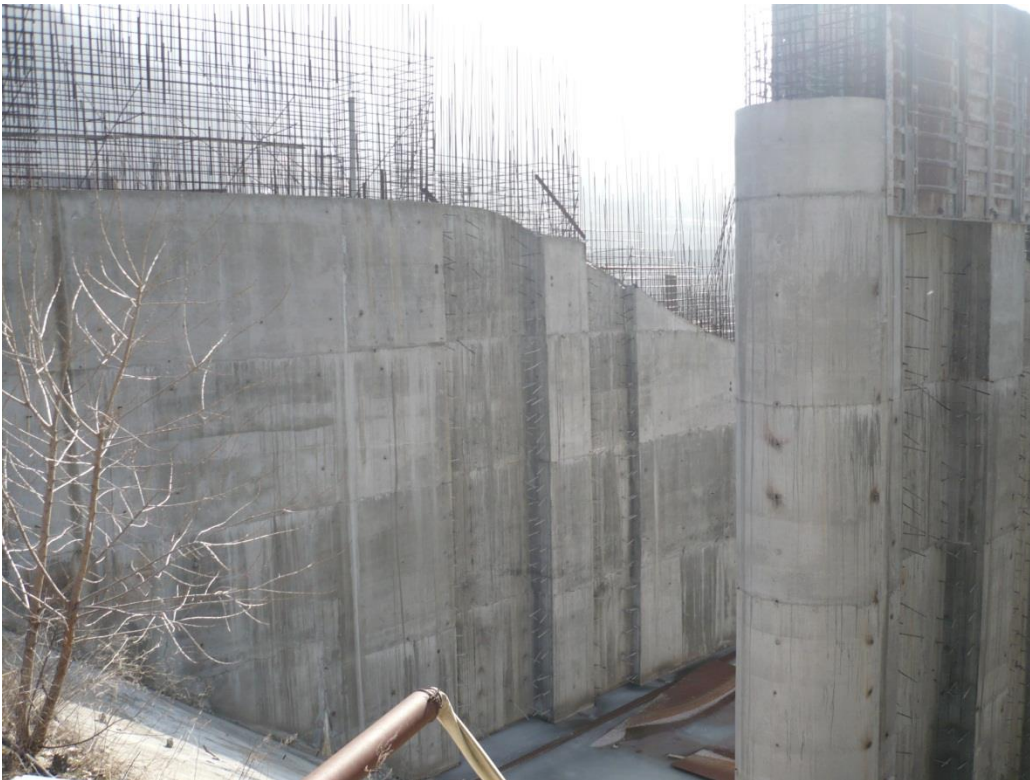
Centrala – zona prizei-vedere din amonte
