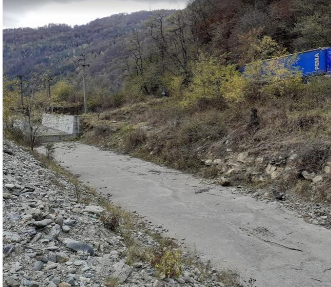
Canalul colector existent centrala hidroenergetica Caineni
