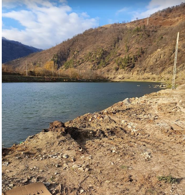
Traseul canalului de fuga
