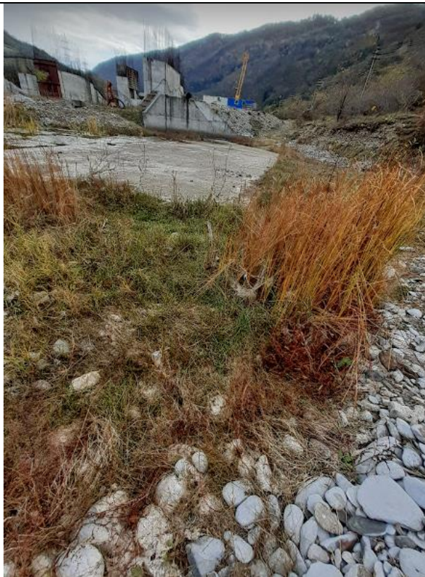
Incinta amenajarii hidroenergetice Caineni
