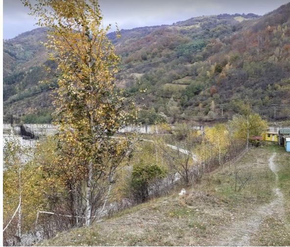
Incinta amenajarii hidroenergetice Caineni
