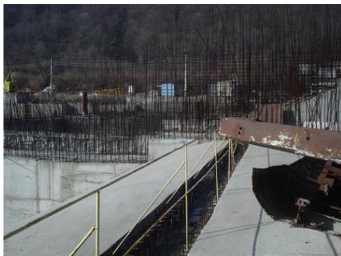
Stadiu execuție pile baraj deversor
