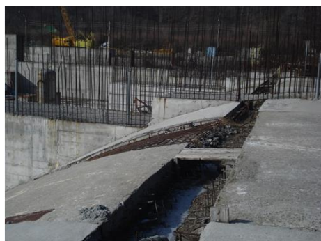
Stadiu execuție pile baraj deversor și prag deversor
