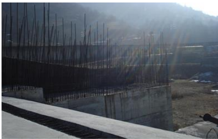
Stadiu execuție pile baraj deversor - vedere de pe prag deversor
