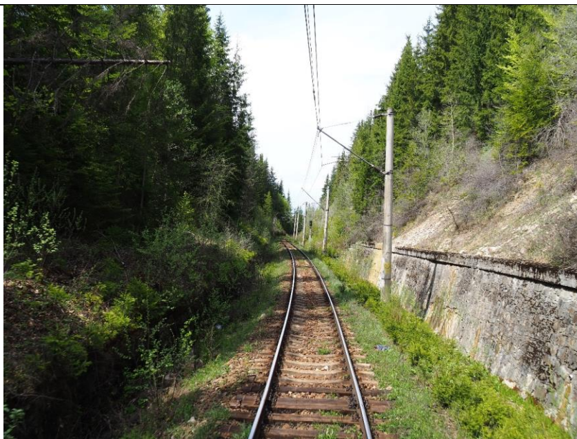
Molidet de-o parte si de alta cu taluz betonat de protectie
