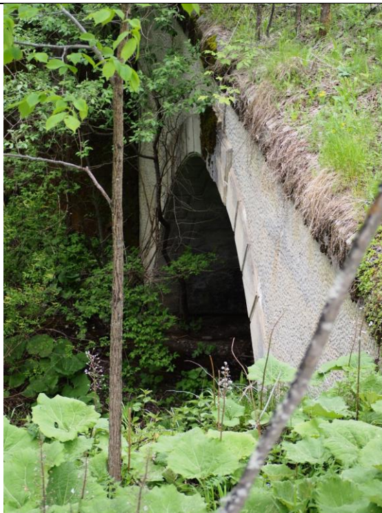
Intersecția supratraversării CFR cu Raul Silhoasa- detaliu pe zona de subtraversare a raului.
