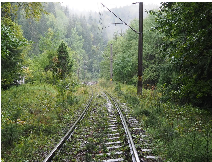
Foto de detaliu asupra zonei de intersecție directă aliniament existent CFR cu ROSCI0101 Larion
