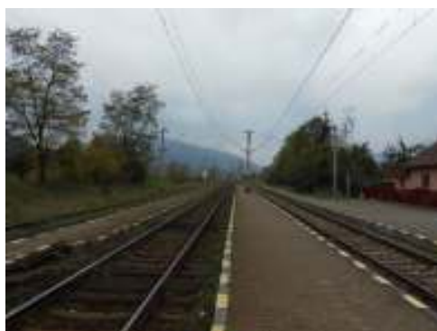
Linii c.f. Halta de mișcare Vama
