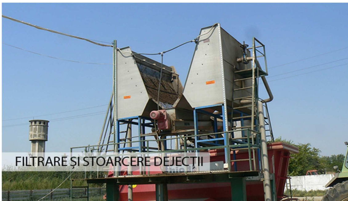
Figură 9: instalație pentru filtrare și stoarcere deșeurii
