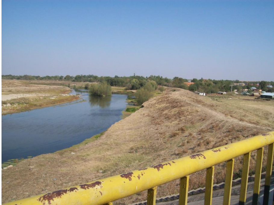
Malul stâng erodat la baza digului – vedere de pe pod înspre amonte
