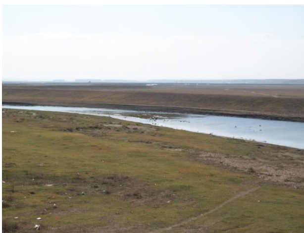
Foto 10.3.2. Zona imediat aval de pod
