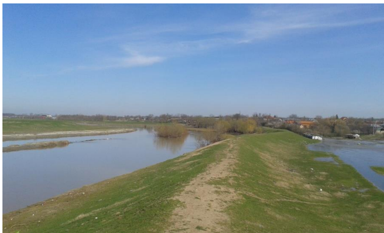
Foto 10.3.3. Digul de apărare mal stâng
