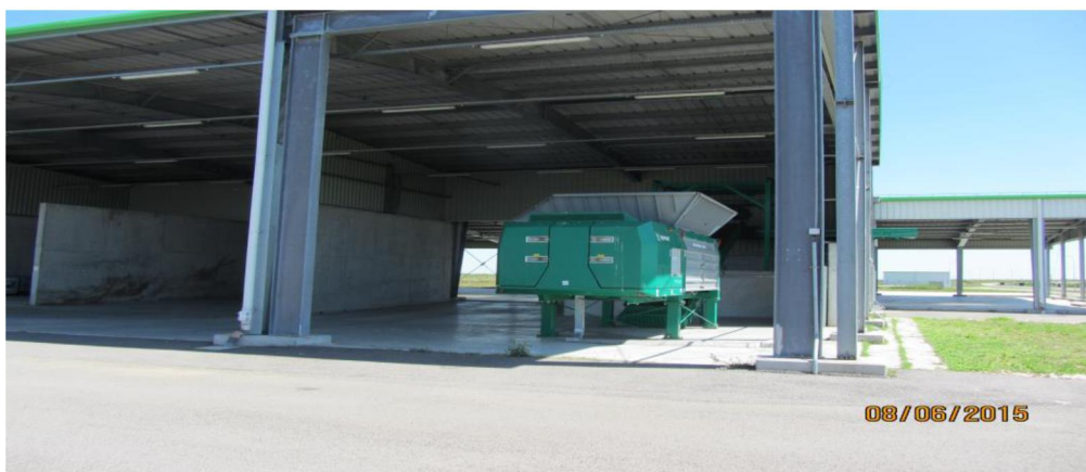
Stația de compostare SC ECO SUD SA București- Depozit Mavrodin
