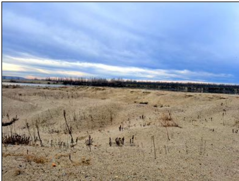
Figura nr. 5 – Aspect privind amplasamentul cvasitotal denudat vizat de realizarea lucrărilor de decolmatare (vedere de pe amplasament spre nord)
