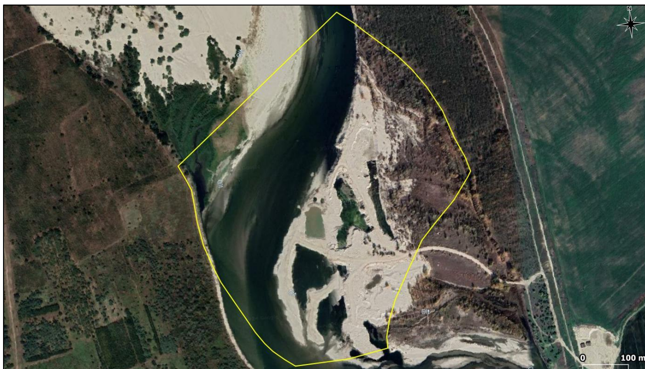
Figura nr. 8 – Aspect general al amplasamentului proiectului (captură imagine satelitară realizată în august 2021)
