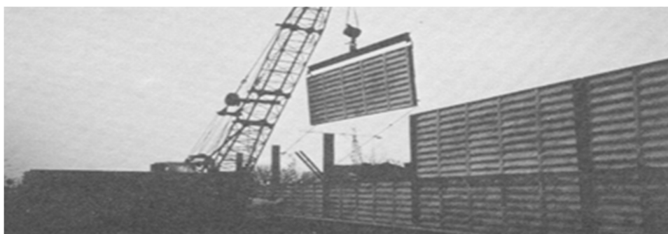
Figura 127. Exemplu de panouri acustice din beton armat
