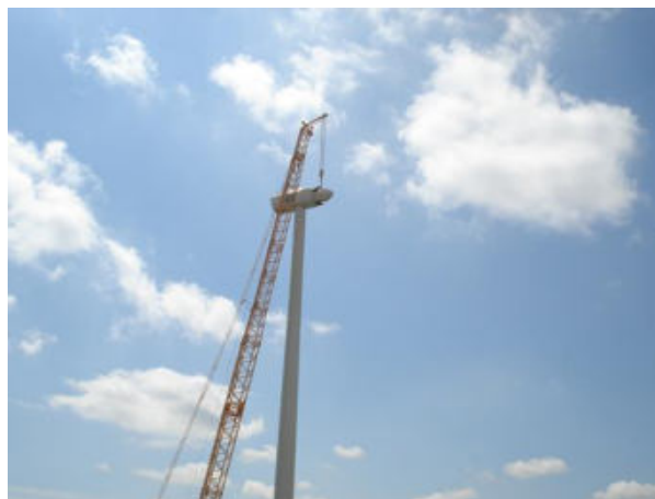
Fig. 8- asamblare turbina
