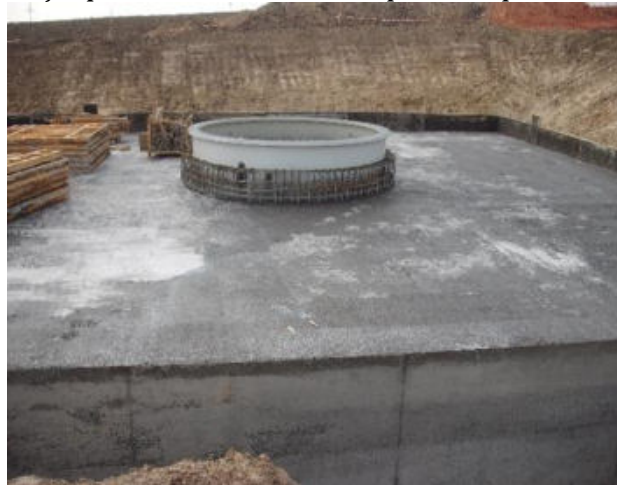
Fig. 7- fundatie turbine eoliana- foto original Badea Gh.
