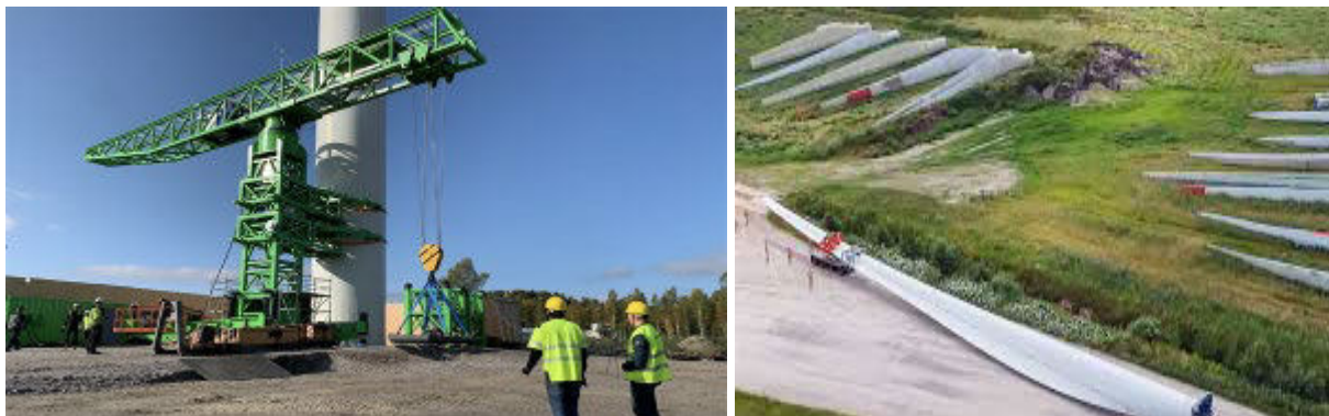
Imagini de la realizarea unui parc eolian
