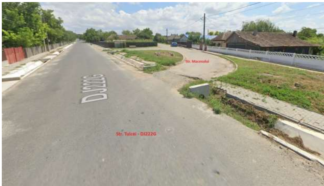
Intersectie Str. Tulcei (DJ222G) – Str. Macesului
