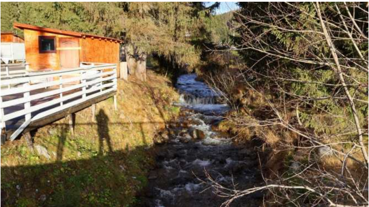
Fig. nr. 20. Pravățul Mare mărginește amplasamentul la vest.
