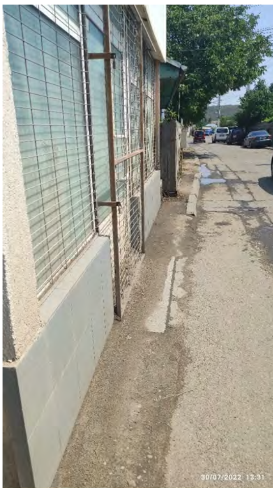
Figura nr. 36 Infrastructură pietonală inadecvată deplasării pe jos
