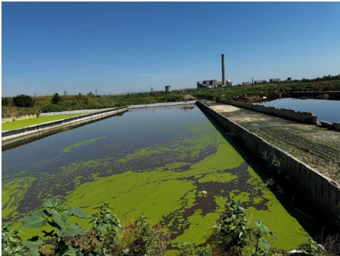
Situația actuală a batalurilor – conțin apă pluvială și vegetație diversă
