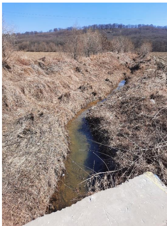
Foto I.1. Canal în zona de intersecție DN2-A8
