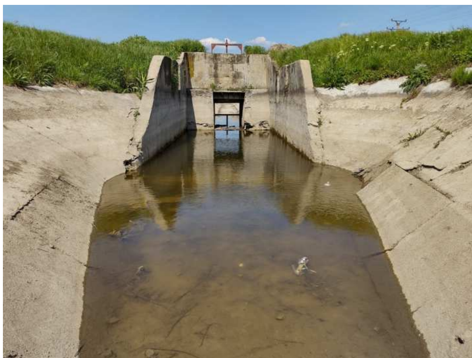
Canalul de aductiune CA1C
