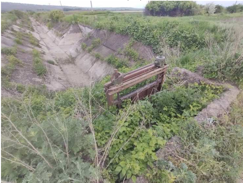
Canalul de aductiune CA2C
