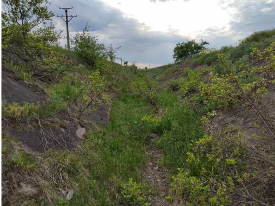
Canalul de aductiune CA2C
