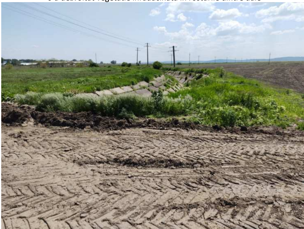
Canalul de aductiune CA1C
