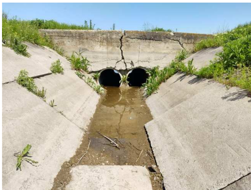
Canalul de aductiune CA1C
