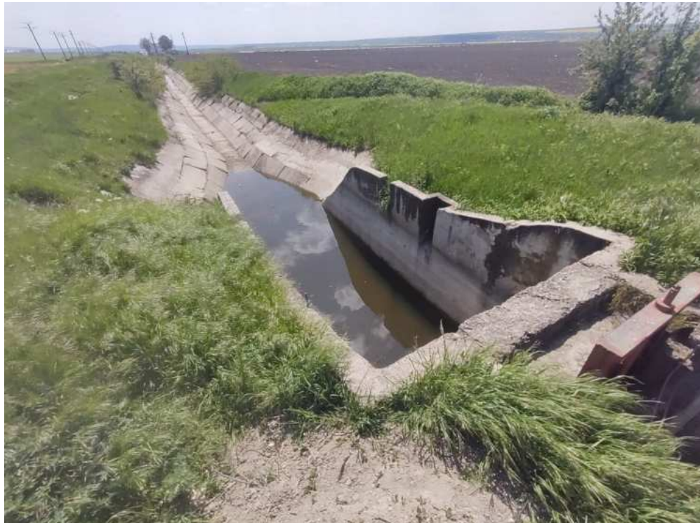
Canalul de aductiune CA1C
