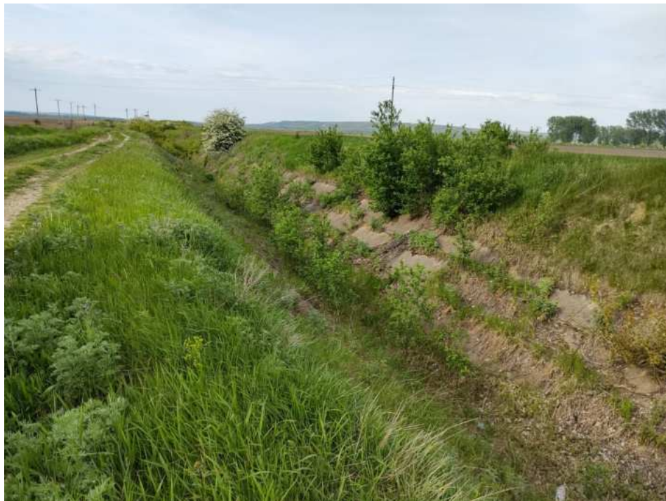
Canalul de aductiune CA2C
