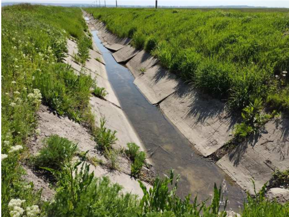
Canalul de aductiune CA1C
