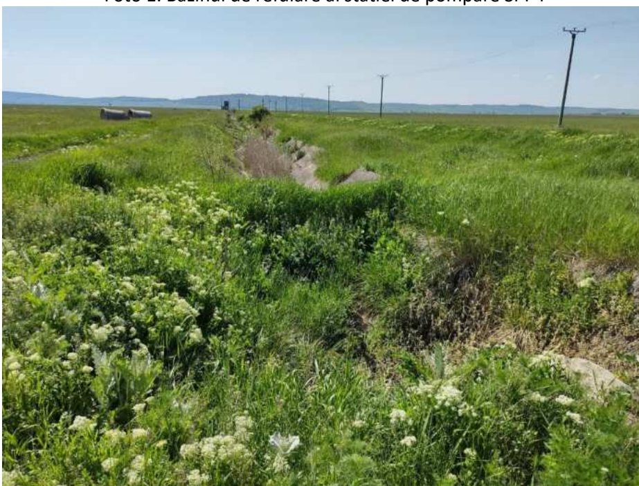
Foto 1. Bazinul de refulare al statiei de pompare SPP4
