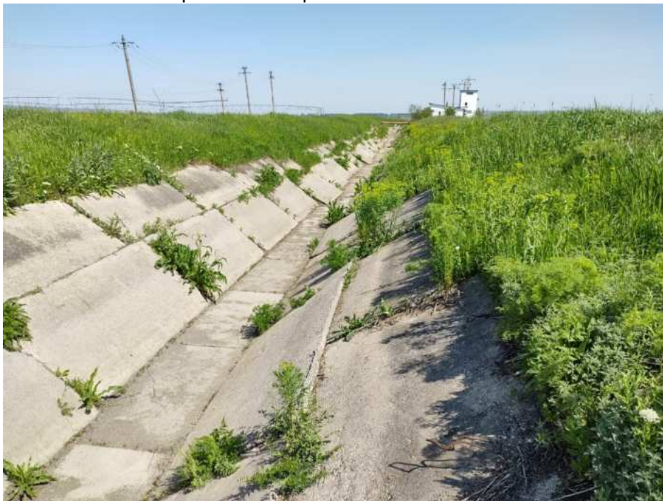
Canalul de aductiune CA1C
