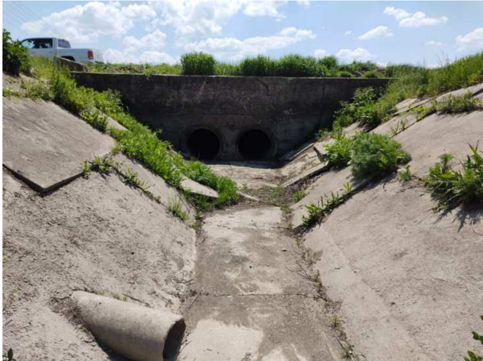
Canalul de aductiune CA1C
