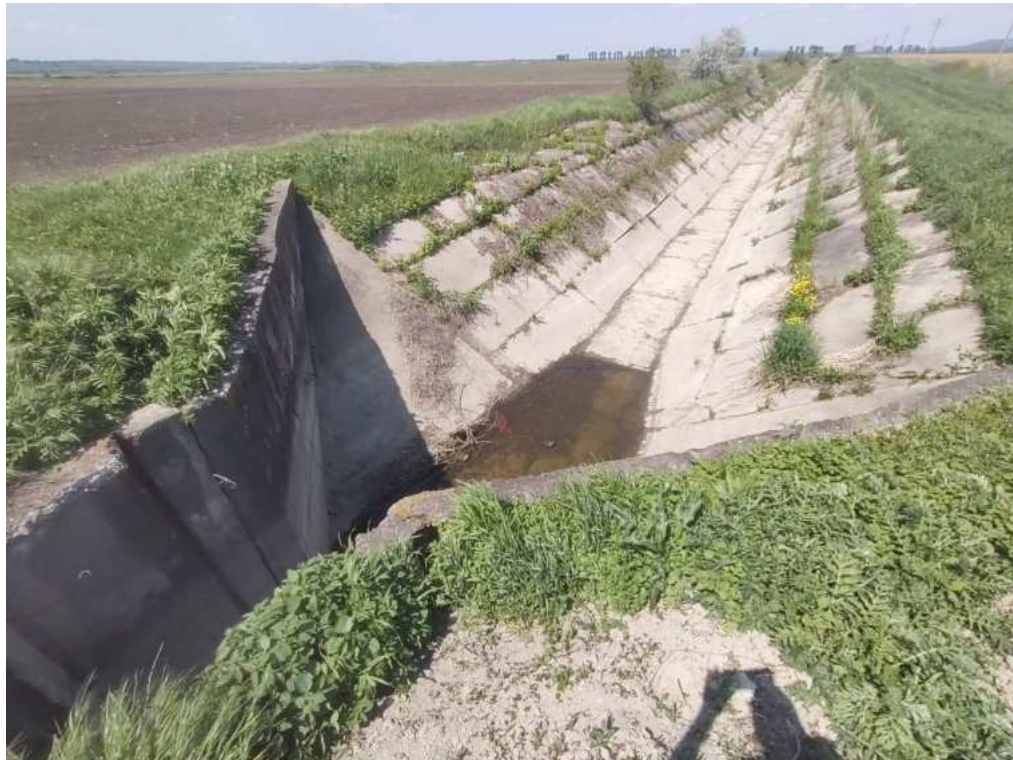
Canalul de aductiune CA1C
