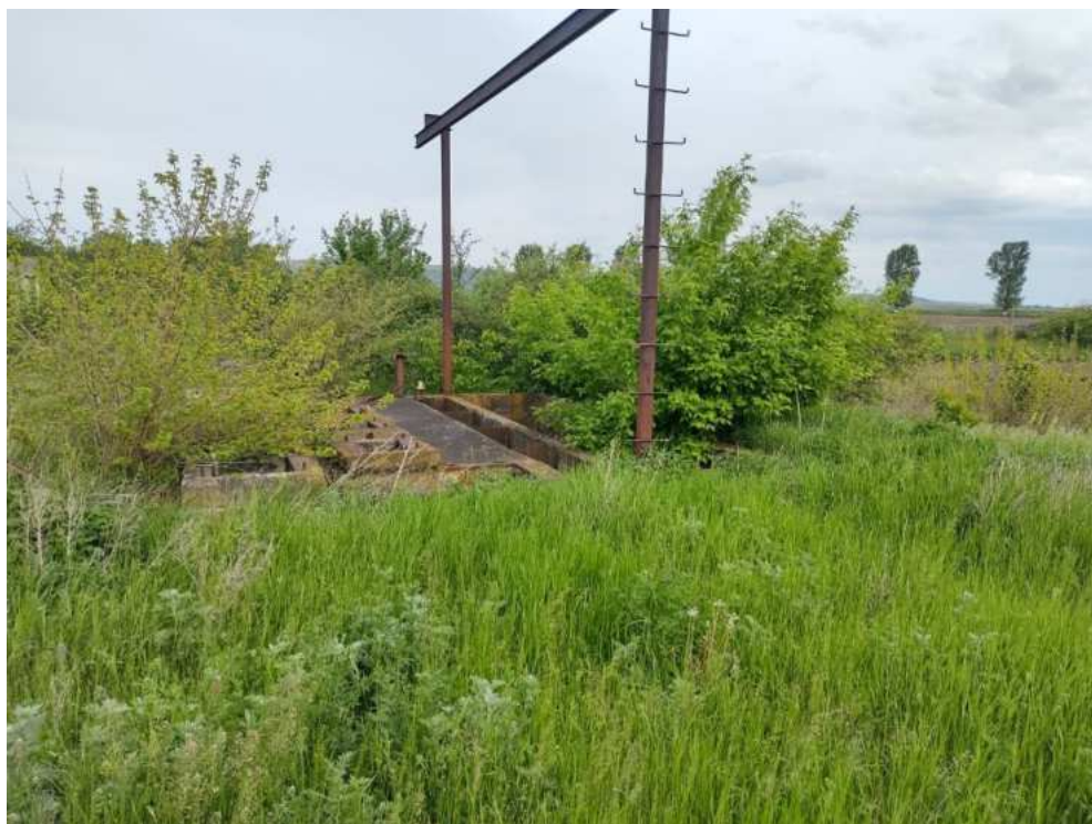
Canalul de aductiune CA2C
