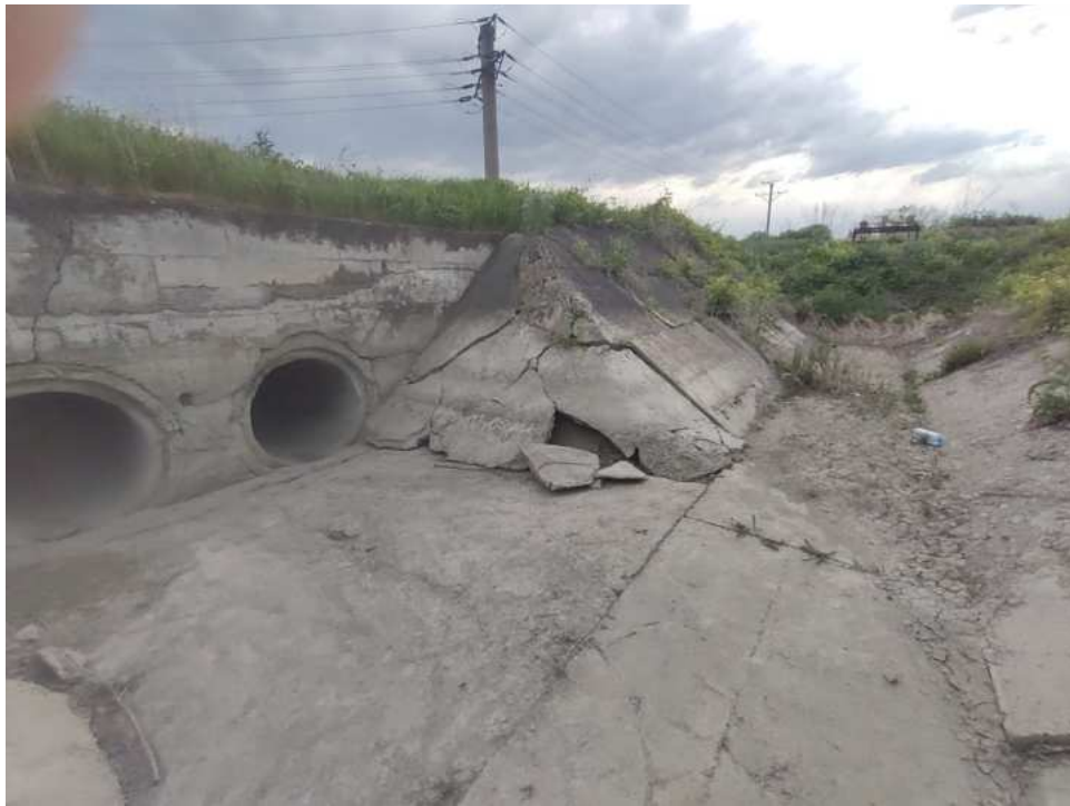
Canalul de aductiune CA2C
