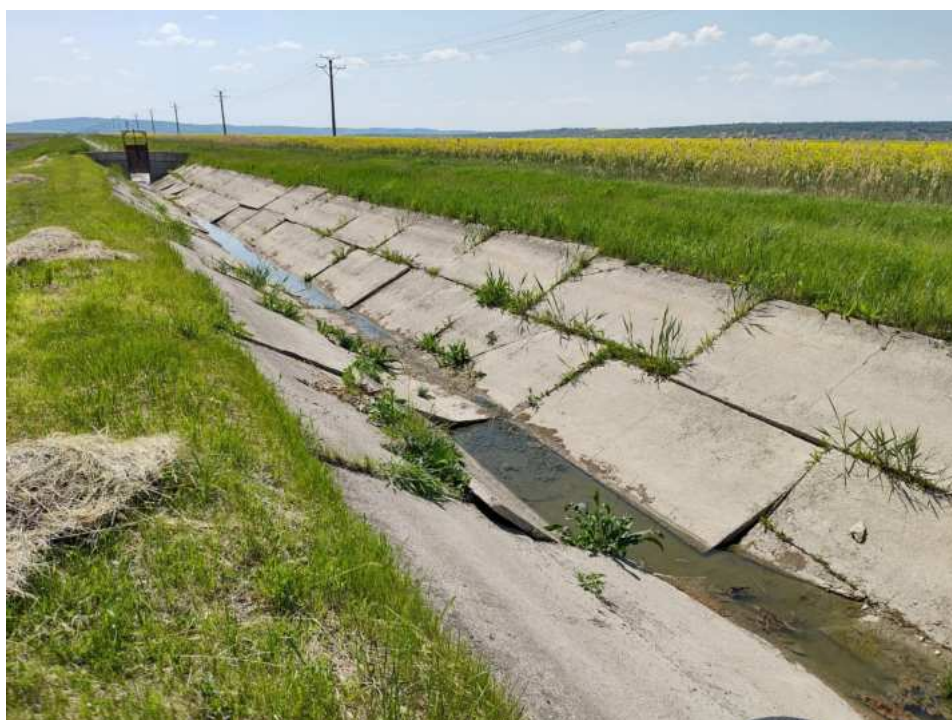
Canalul de aductiune CA1C
