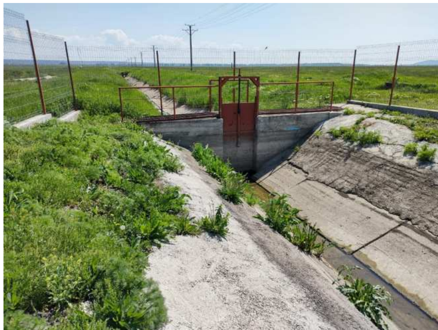
Canalul de aductiune CA1C
