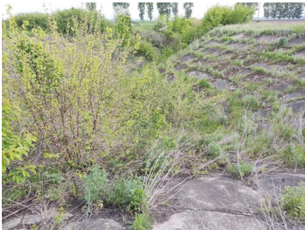
Canalul de aductiune CA2C
