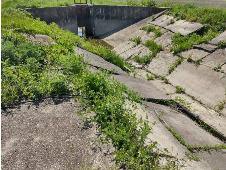
Canalul de aductiune CA1C
