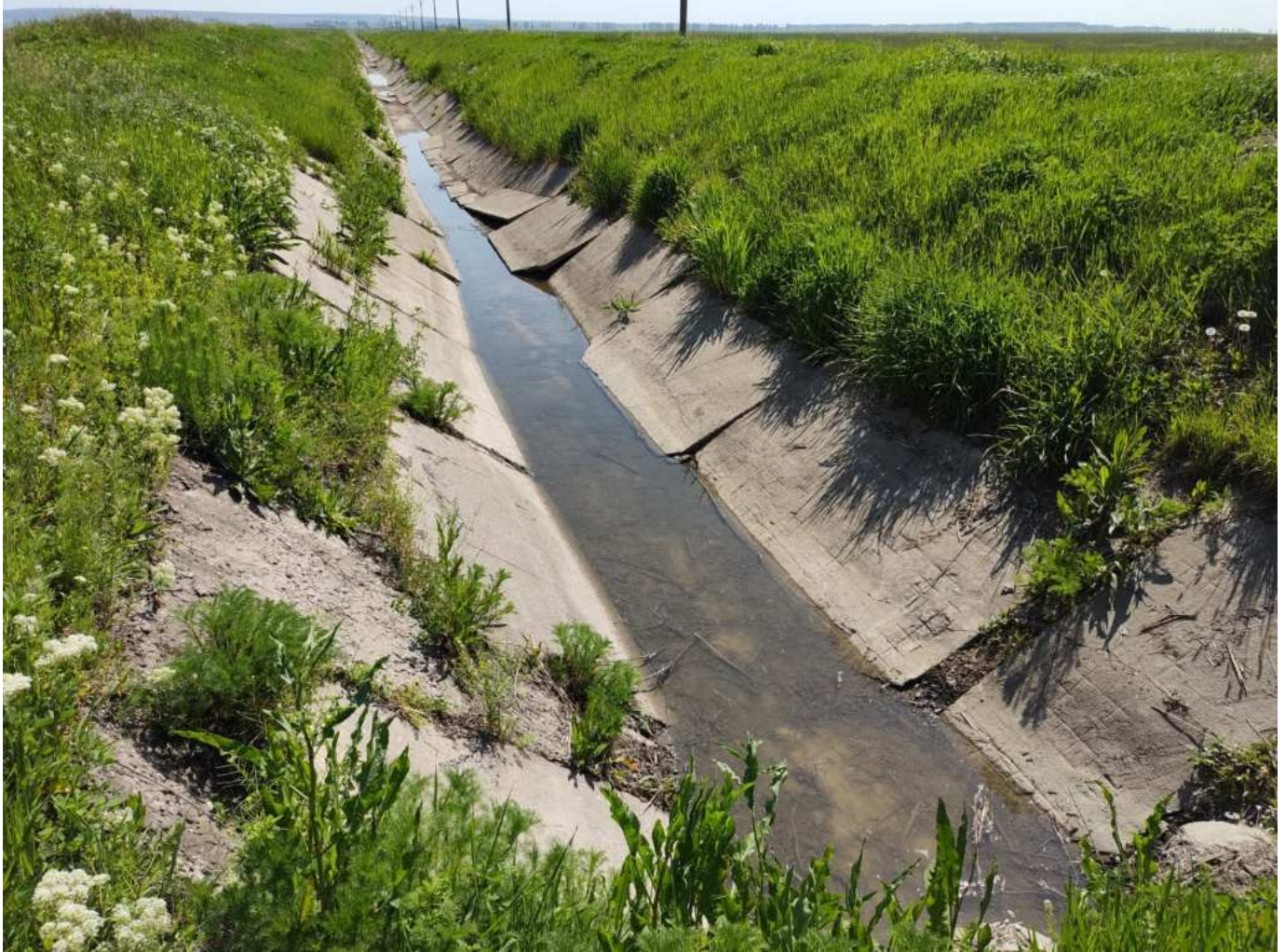
Canalul de aductiune CA1C
