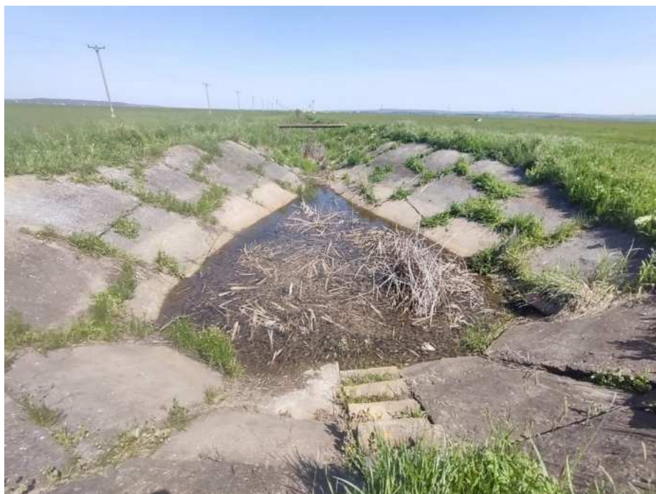
Canalul de aductiune CA3C
