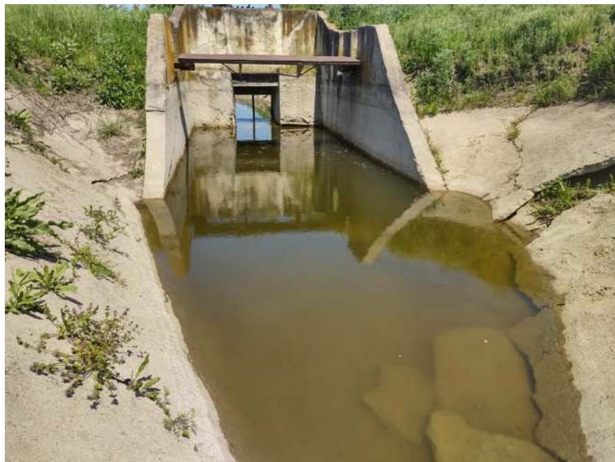
Canalul de aductiune CA1C
