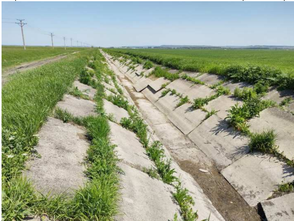
Canalul de aductiune CA1C
