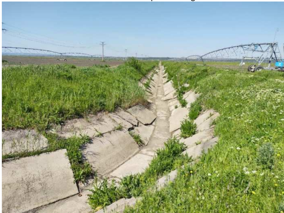
Canalul de aductiune CA1C Foto 20. Perek deteriorat si napadit de vegetatie ierboasa
