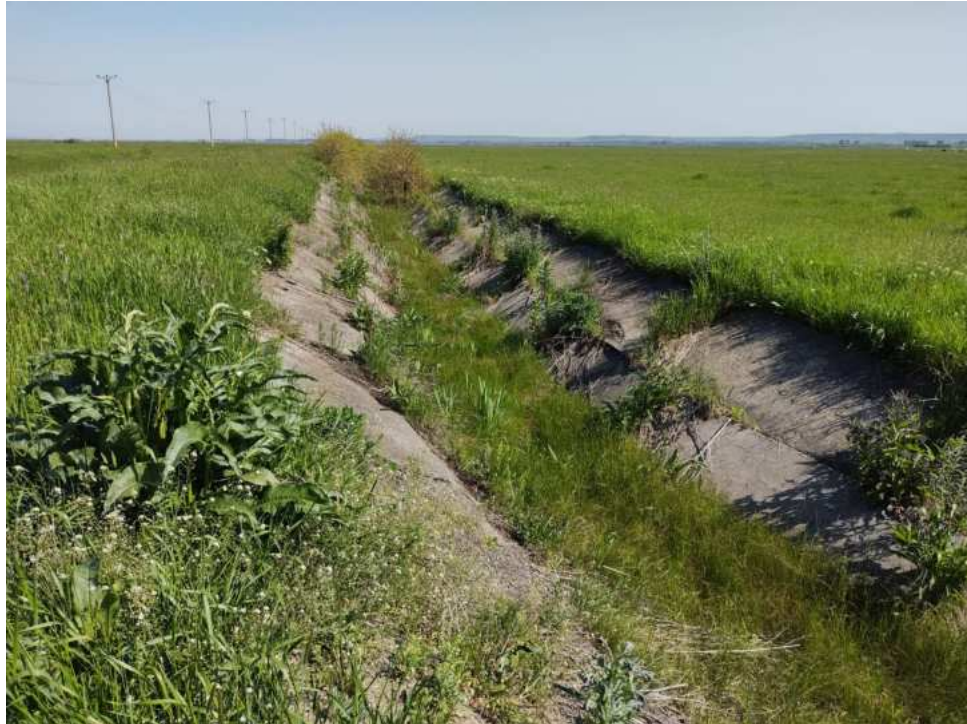
Canalul de aductiune CA1C Foto 20. Perek deteriorat si napadit de vegetatie ierboasa
