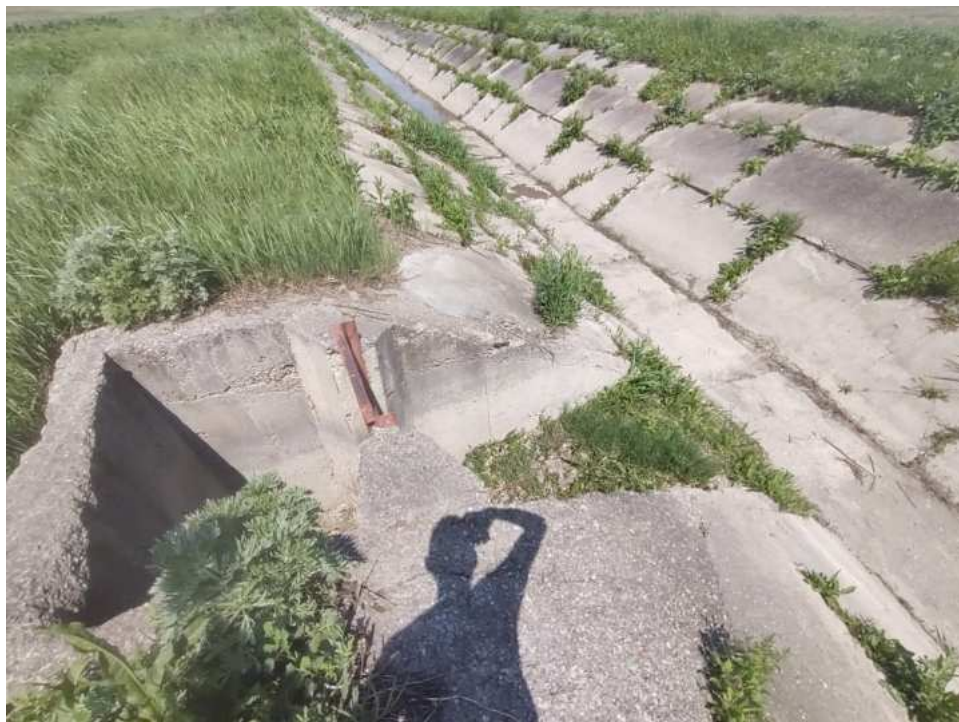
Canalul de aductiune CA1C
