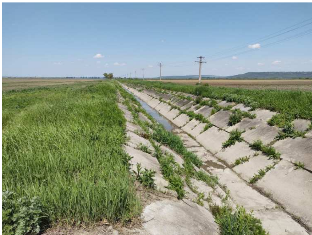
Canalul de aductiune CA1C
