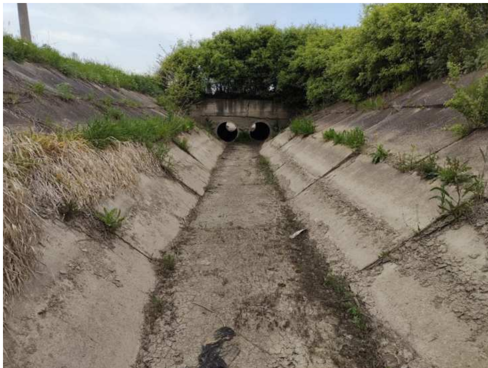
Canalul de aductiune CA1C Foto 24. Podet tubular cu 2 fire.
