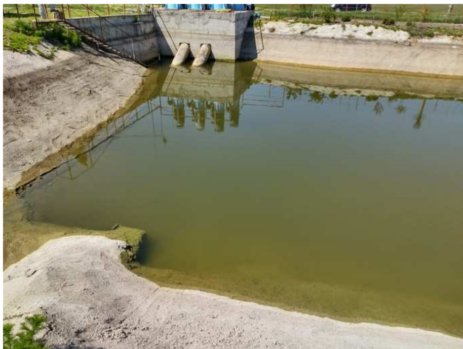
Canalul de aductiune CA1C
