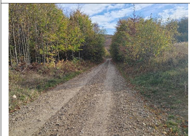
Figură 6 Vedere DF
