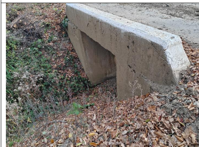
Figură 5 Podete existente
