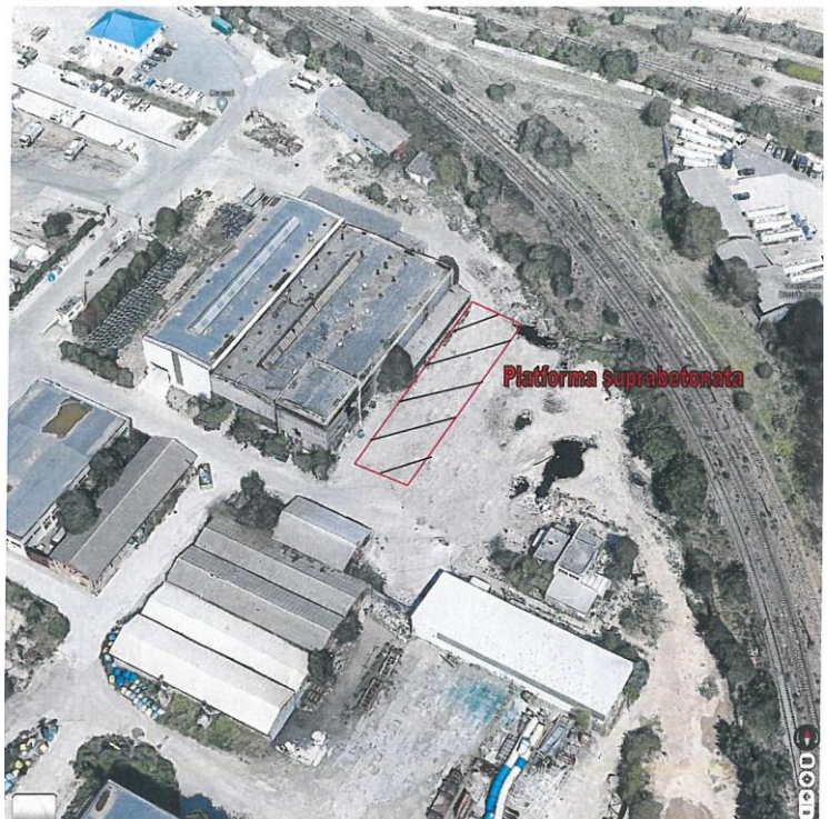
e) Fig. 2 platforma betonată ce urmează a fi reabilitată
