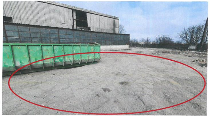
Fig. 3 platforma betonată ce urmează a fi reabilitată
