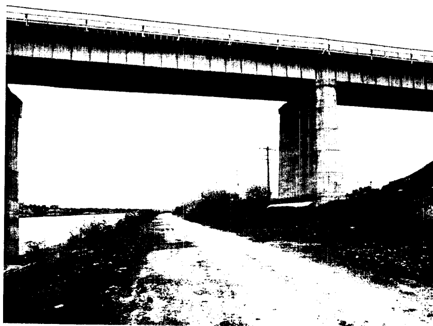
Drum acces in zona – zona de nord a obiectivului
