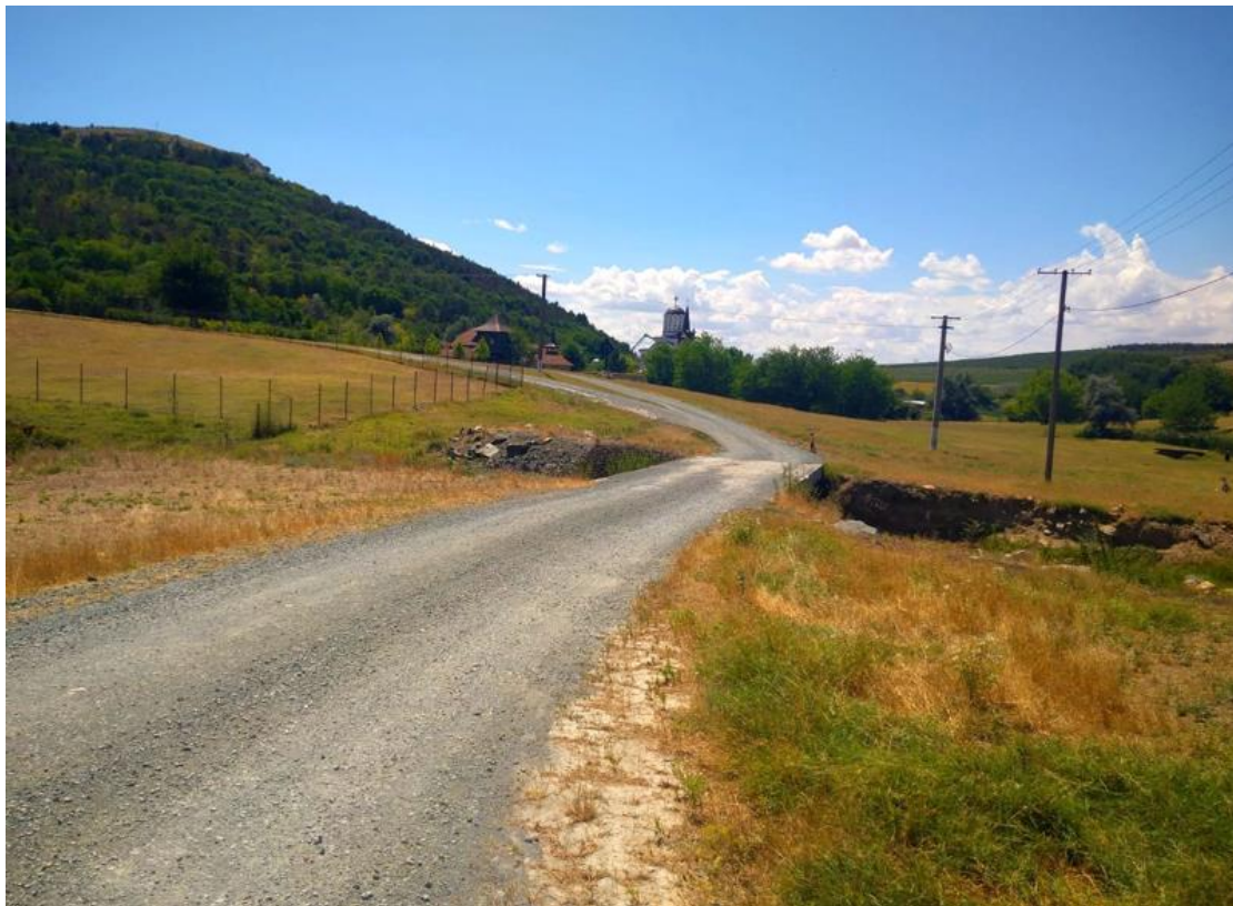
Figura 1 Foto din zona amplasamentului
