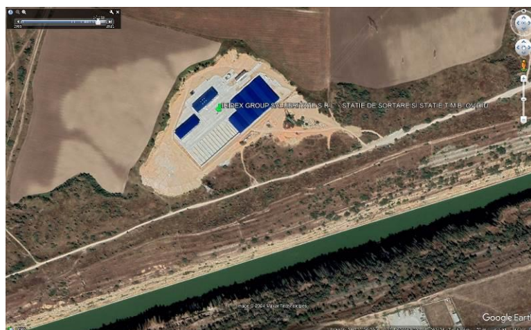
Figura 53 – Situația amplasamentului în septembrie 2018
