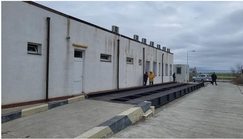
Figura 47 – Etapa de recepție. Vedere asupra clădirii administrative și cântarului auto
