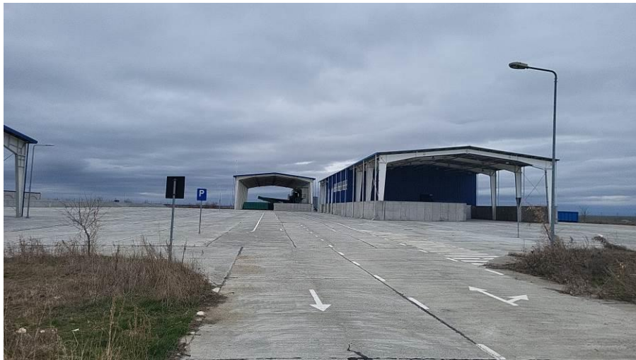
Figura 46 – Etapa de recepție. Vedere asupra stației de sortare și șopron tratare mecanică
