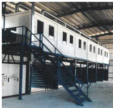
Figura 7 – Cabina de sortare climatizată
