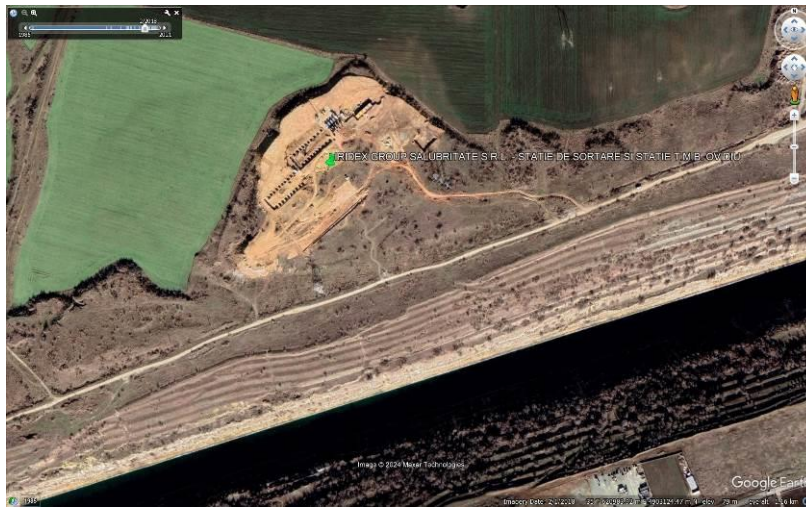
Figura 51 – Situația amplasamentului în februarie 2018
