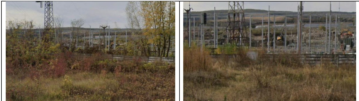
Zona Stația 110/20 kV Doicești
