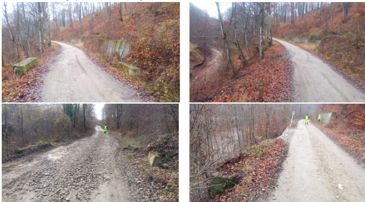
Figura 1. Aspecte ale stării actuale a amplasamentului proiectului
